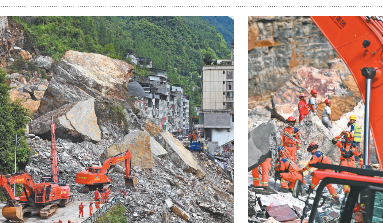
上图、右图：7月18日，彭水县山体崩塌灾害现场，救援人员正在进行搜救作业。 本报记者 陈 斌摄
